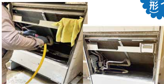
内部洗浄作業
